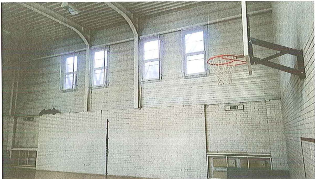
Zdjęcie nr 1 – Sala gimnastyczna od strony wschodniej
