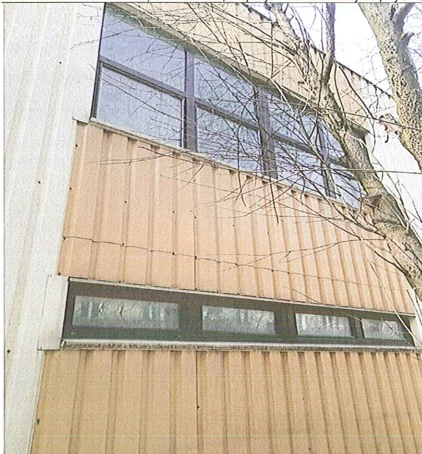
Zdjęcie nr 19 – Elewacja od strony wschodniej
