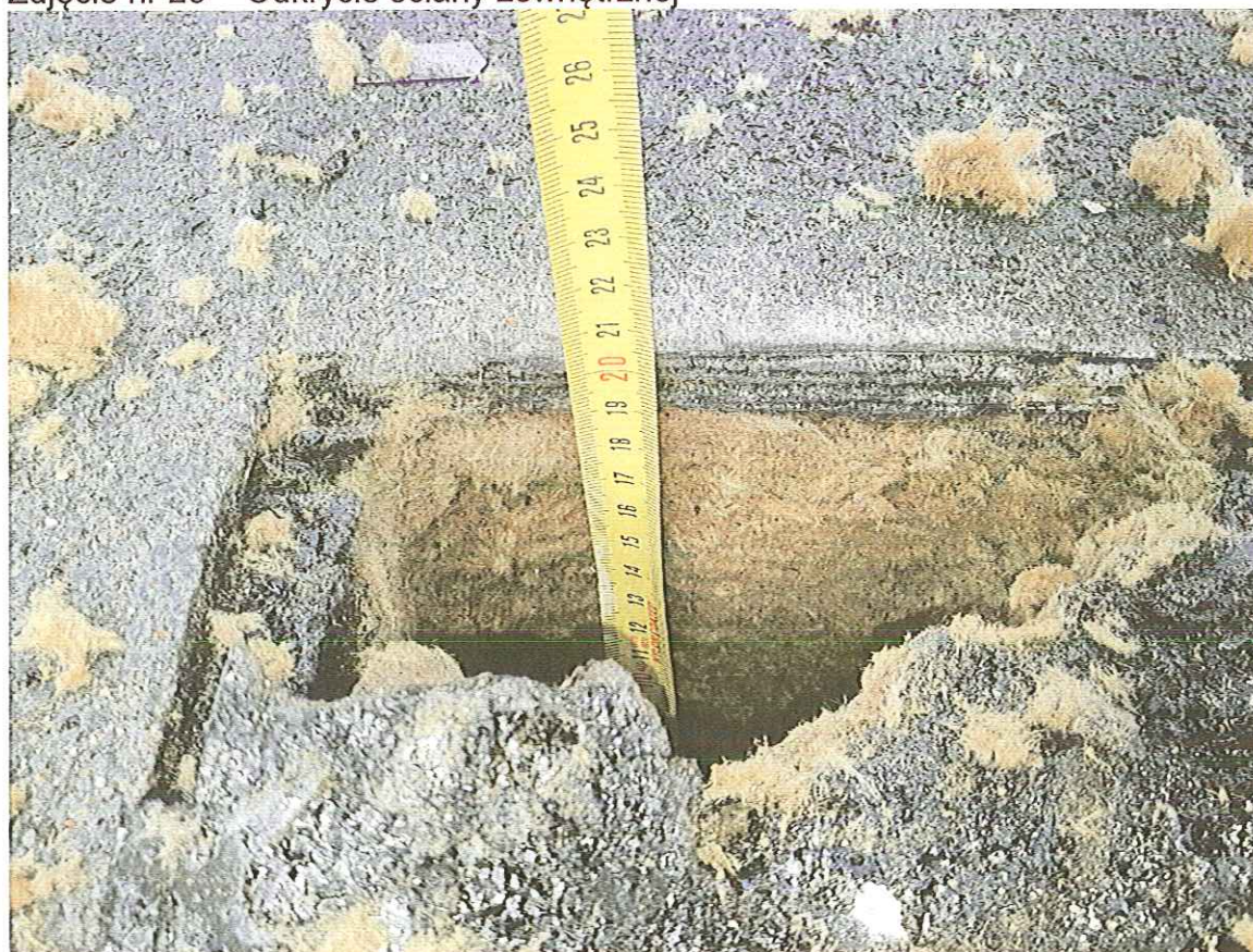
Zdjęcie nr 26 – Odkrycie warstw dachowych
