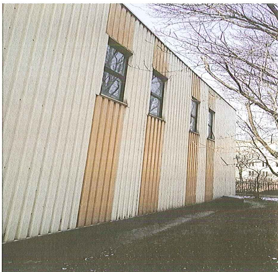
Zdjęcie nr 20 – Elewacja od strony wschodniej
