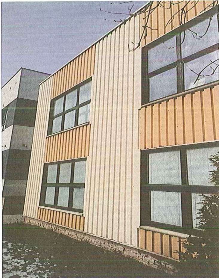
Zdjęcie nr 18 – Elewacja od strony południowej
