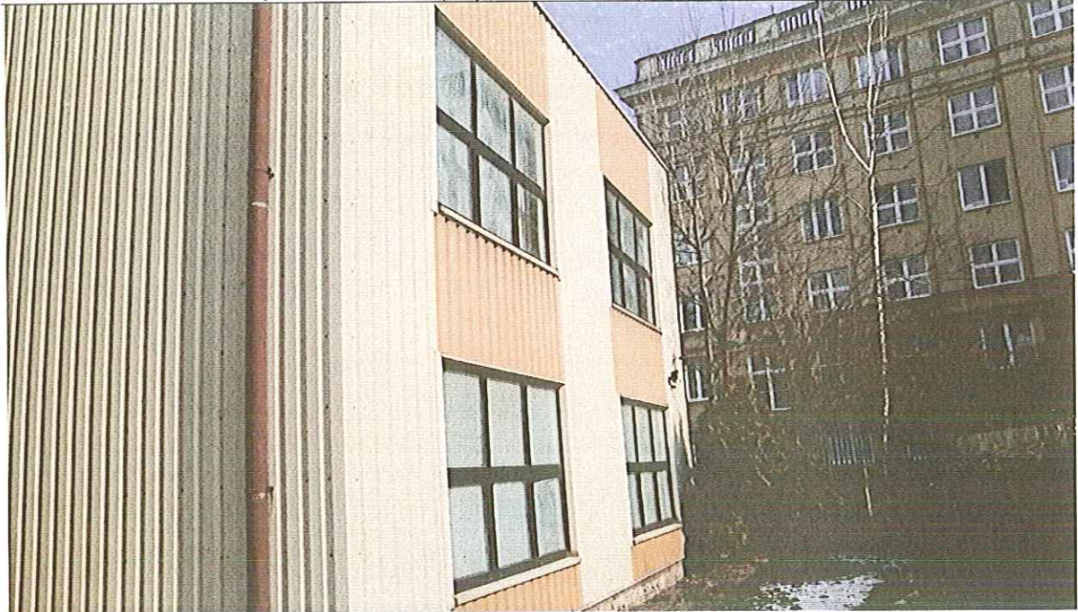
Zdjęcie nr 17 – Elewacja od strony południowej
