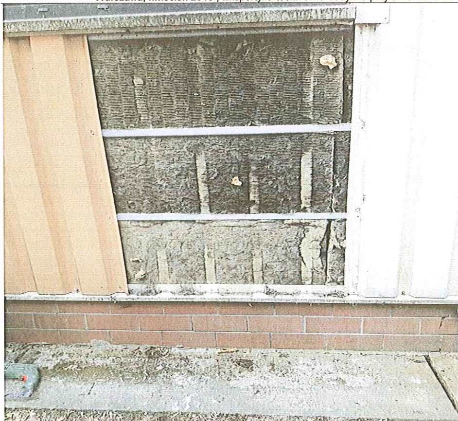
Zdjęcie nr 25 – Odkrycie ściany zewnętrznej
