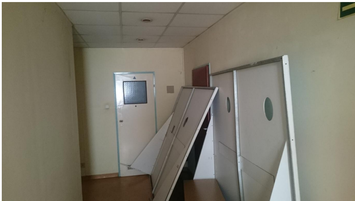
Zdjęcie nr 5 – Korytarz na parterze
