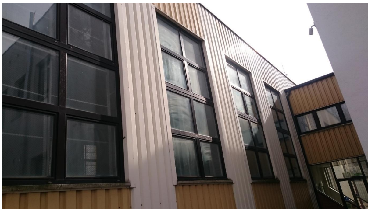
Zdjęcie nr 14 – Elewacja wraz z łącznikiem od strony zachodniej
