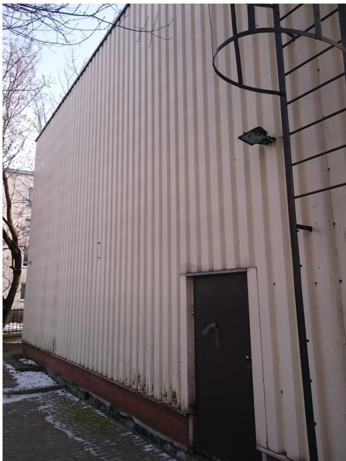
Zdjęcie nr 13 – Elewacja od strony północnej
