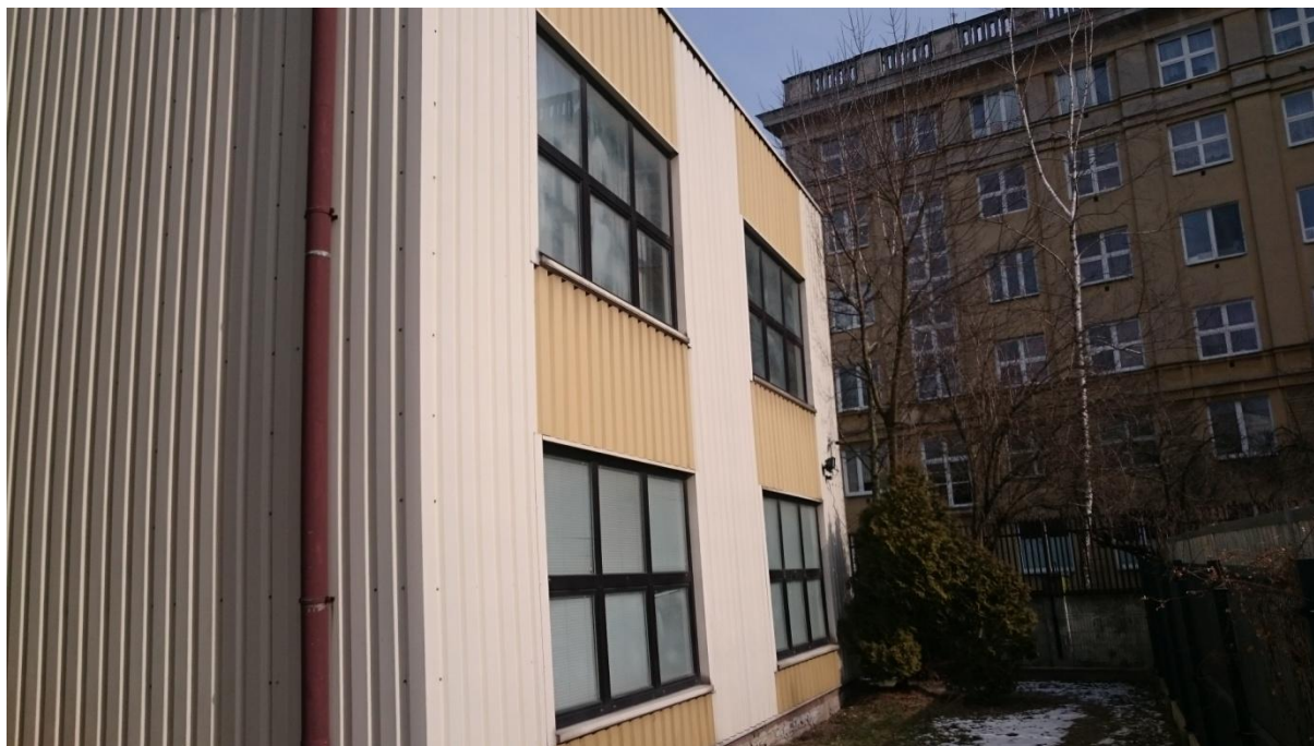
Zdjęcie nr 11 – Elewacja od strony południowej
