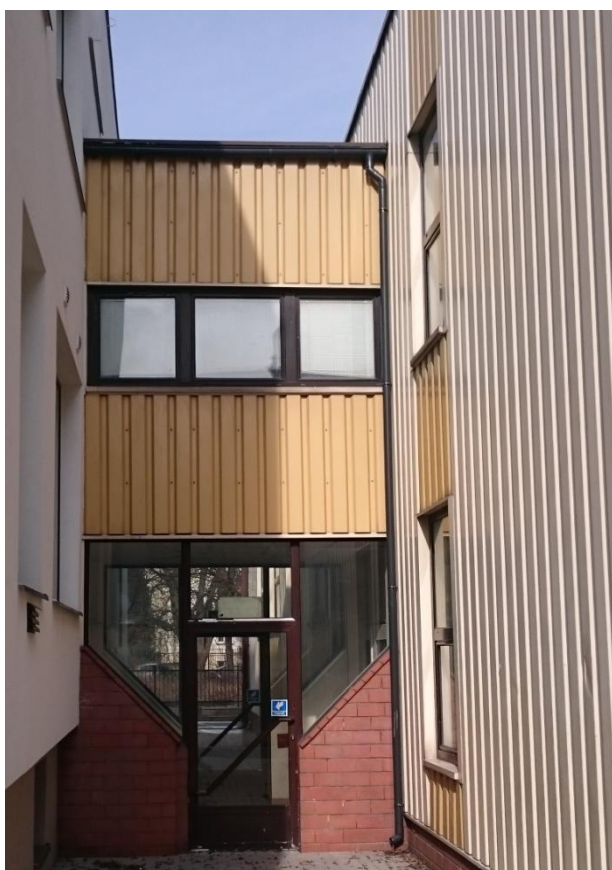
Zdjęcie nr 10 – Łącznik od strony południowej
