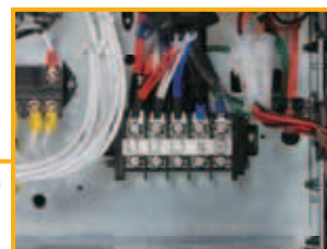
Przyłącza elektryczne jednostki zewnętrznej
